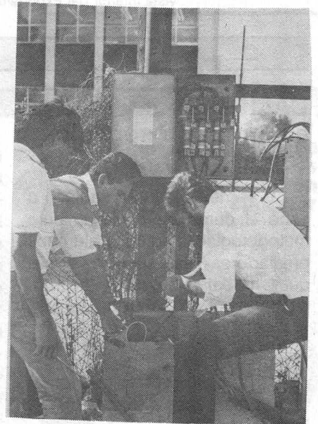
Instalación del control electrónico.
